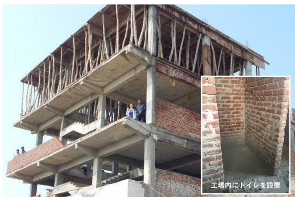
建築が進む工場内にはトイレを設置
